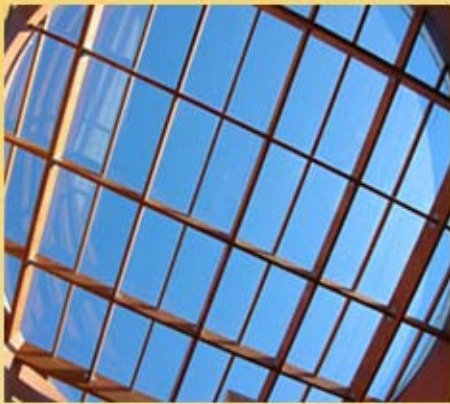
Cubiertas acristaladas y lucernarios
