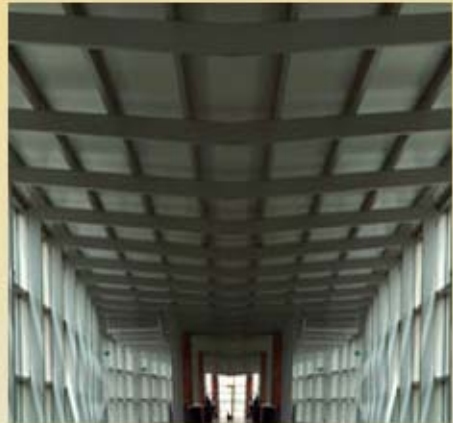
Falsos techos acristalados
