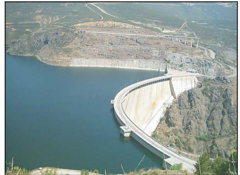
Figura 21: Presa El Atazar.
